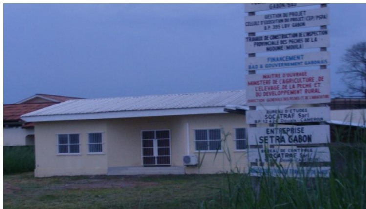
Inspections provinciales Mouila (haut) et Makokou (bas)
